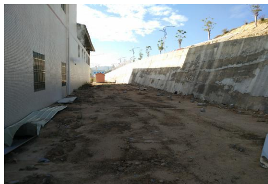
图 9-17 边坡防护工程
