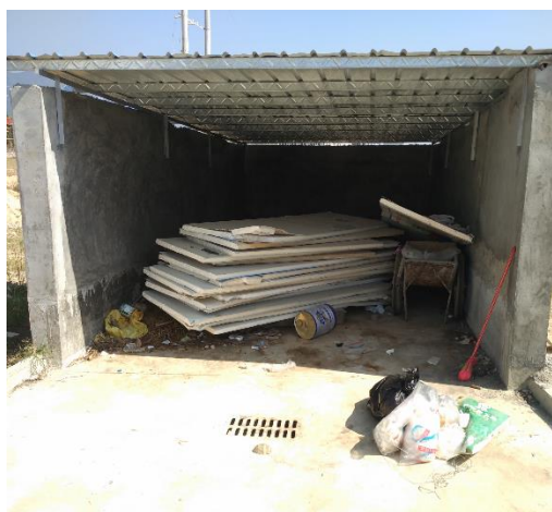
图 9-5 固体废物贮存场
