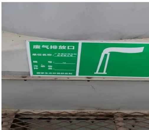
图 9-7 1#排放标识牌排放口
