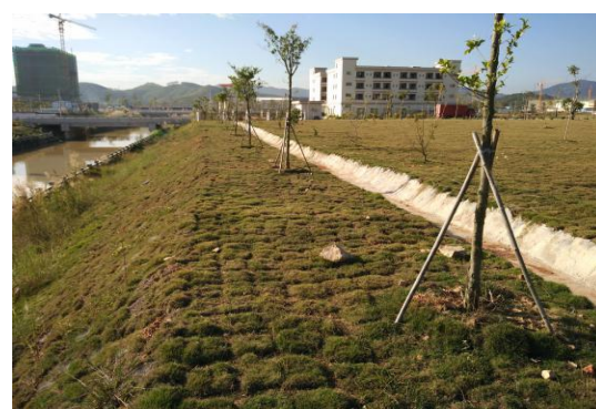
图 9-18 边坡防护工程
