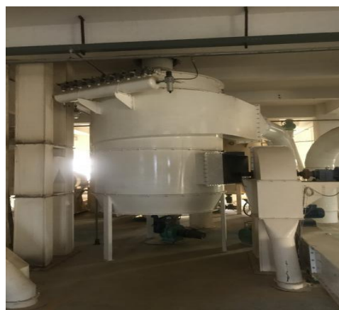
图 4-2 旋风除尘器
